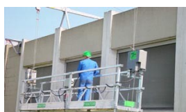
Plataforma de 6 metros de longitud.
